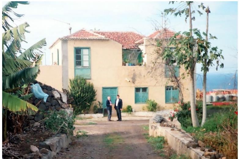
Figura 2.- La Casa Amarilla en 1993 antes de los intentos de demolición.
